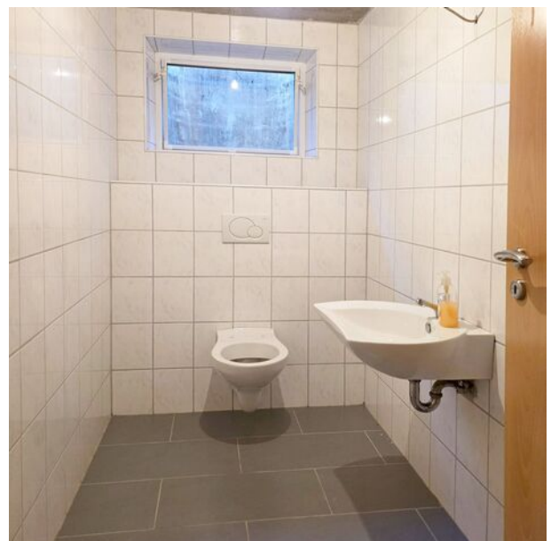
WC im Untergeschoss
